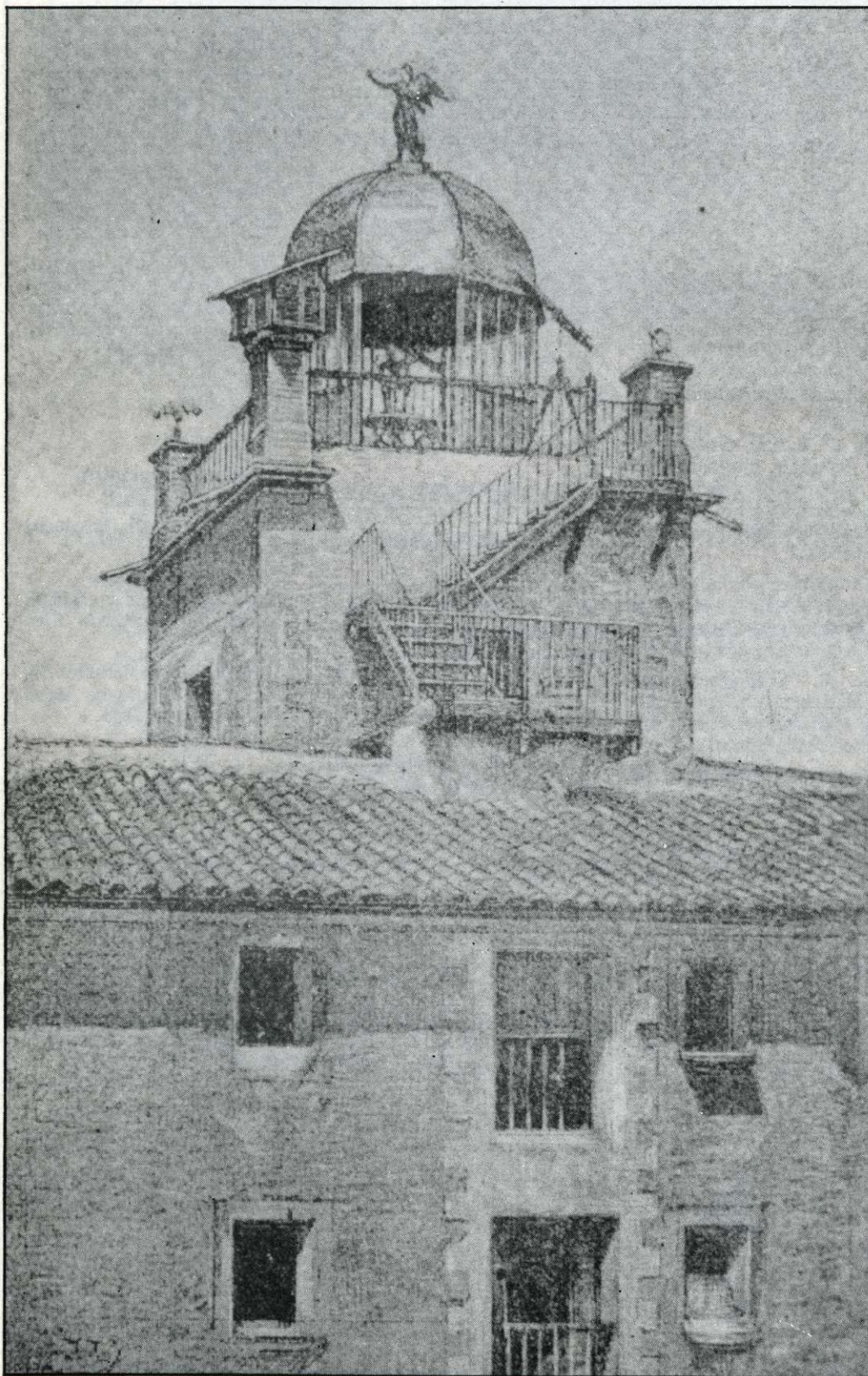
El antiguo observatorio astronómico y meteorológico del Colegio de Escolapios.
