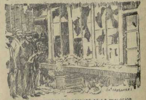
ASPECTO DEL TALLER DESPUES DE LA EXPLOSION
