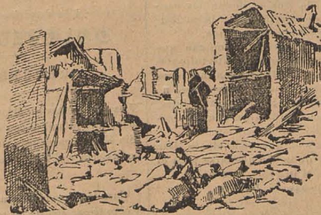
CALLE DE OLIVARES. (DESPUES DEL INCENDIO.)
